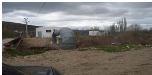
Слика 2. Доводен колектор со пумпна станица
