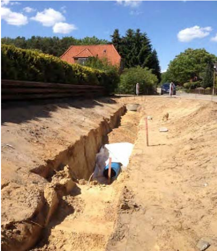
Sistemi i infiltrimit Rigol në ndërtim Foto: Arnd Wendland
