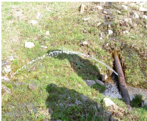
Korozioni mund të shkaktojë rrjedhje serioze në sistemet distributive
