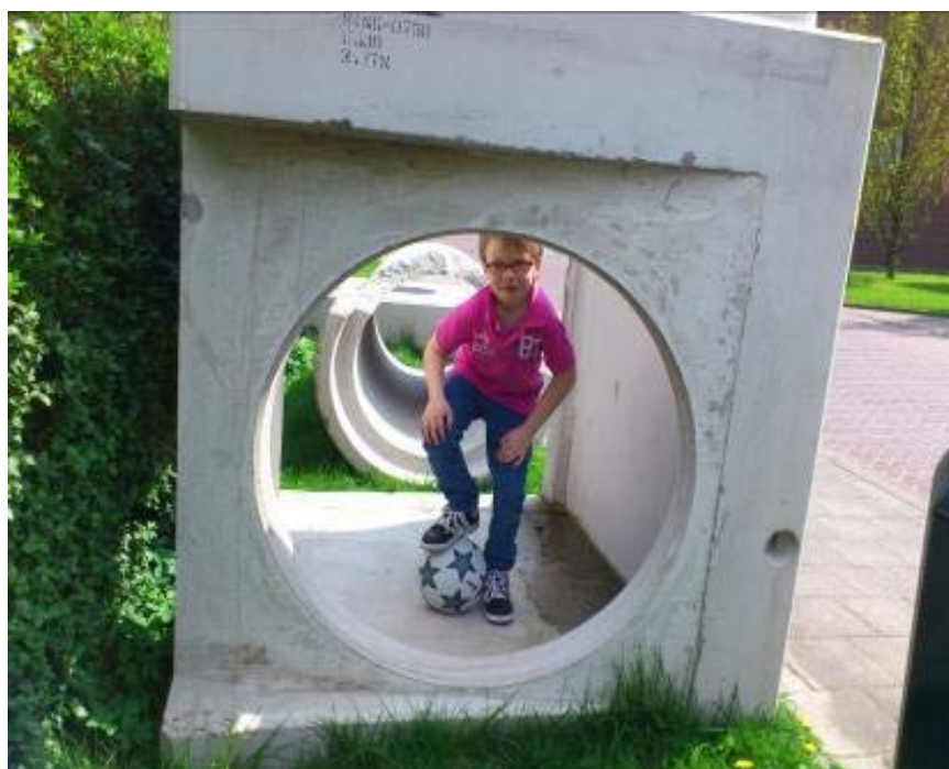
Gyp për mbledhjen e ujërave të zezave vrimë për qasje të njeriut, I cili do të veket nën dhe
