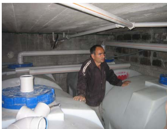
TTHOU i shkollës: bodrum për mbledhjen, deponimin dhe trajtim të urinës për 350 përdorime
